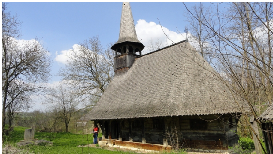
foto 8- biserica de lemn din Nadiş- vedere dinspre sud-est
