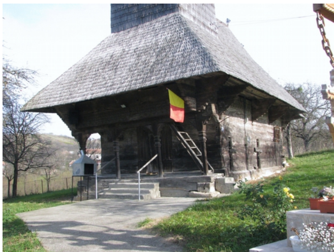
foto 9- pridvorul pe fațada vestică
