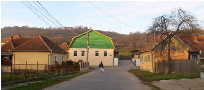
foto 77- casă reabilitată la intersecția str. Păcii cu str. Someșului
