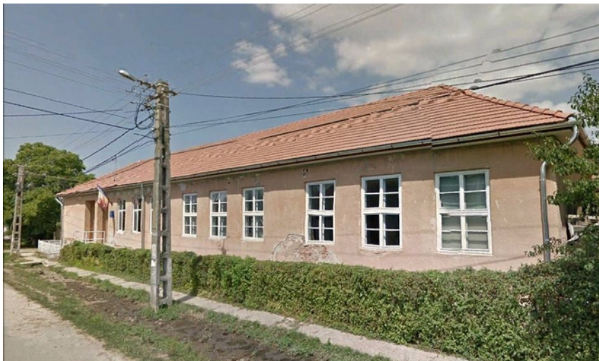
foto 21- școala înainte de reabilitare
