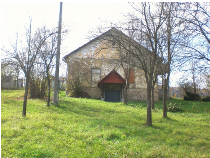
foto 50- conacul- vedere laterală dinspre drum
