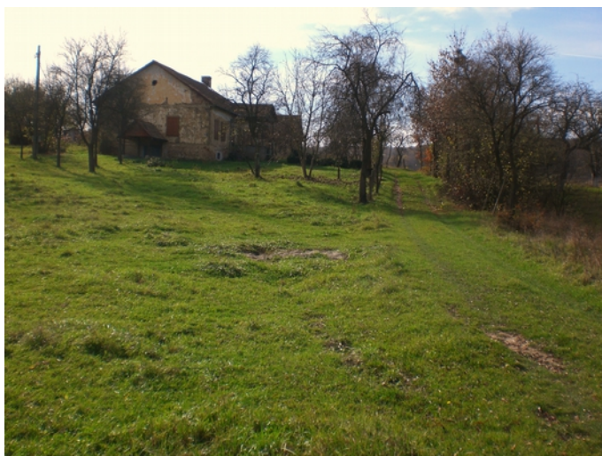
foto 55- parc-aleea mărginită cu arbori
